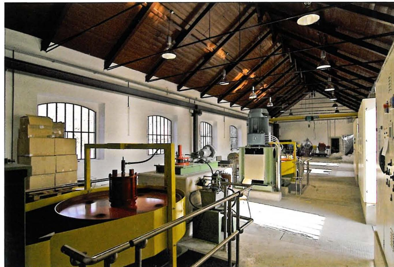
La salle des machines après restauration et transformation, 2009 (blvdr). Animée par deux nouvelles turbines logées dans les passes 3 et 4, la microcentrale électrique produit 2 x 110 kW sous un débit 10 m<sup>3</sup>/s.
